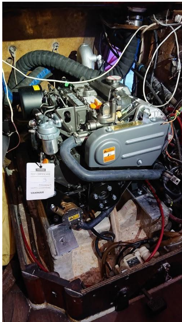
Ny motor installerat på den nybyggda motorbädden.
